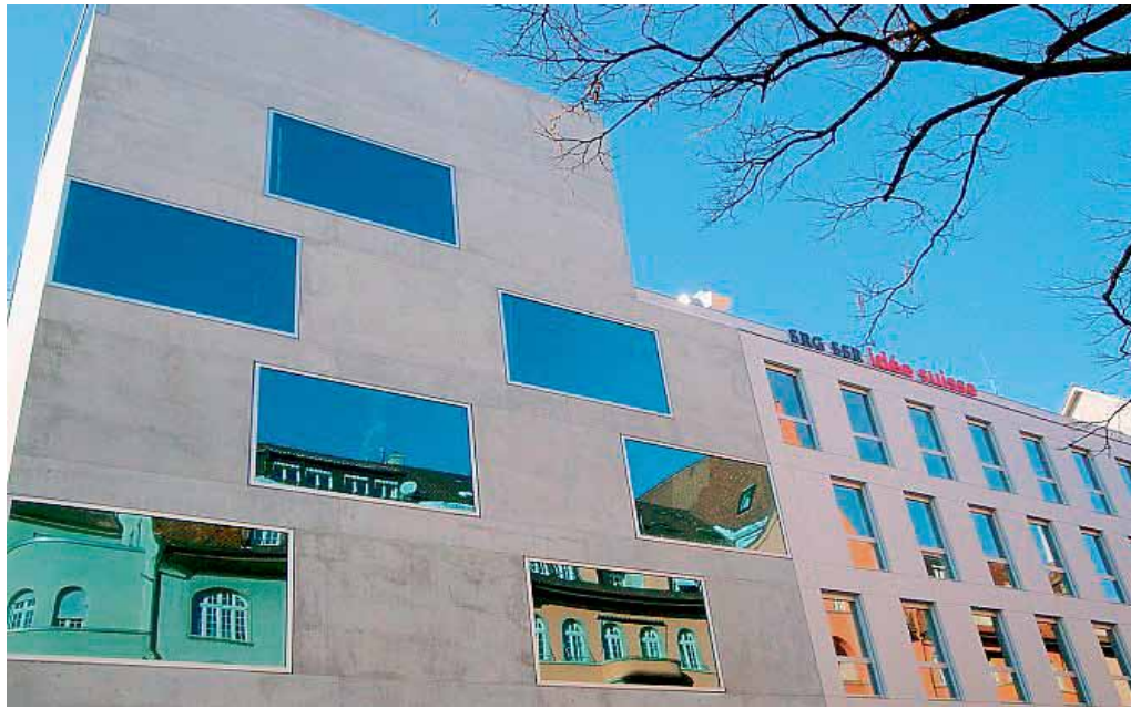
Umbau beendet: das neue Gesicht des Radiostudios Bern.
